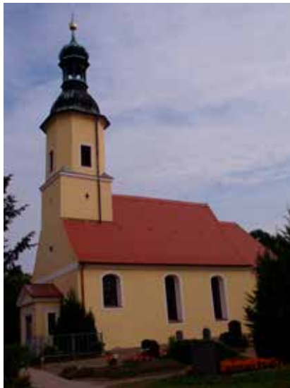
Die wiederhergestellte Außenfassade an der Kirche zu Güldengossa
