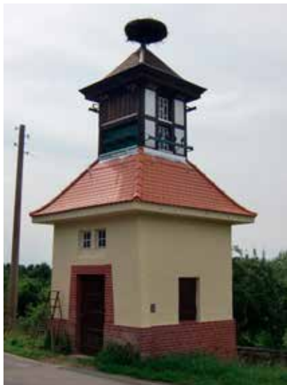
Das Saasdorfer Trafohäuschen
