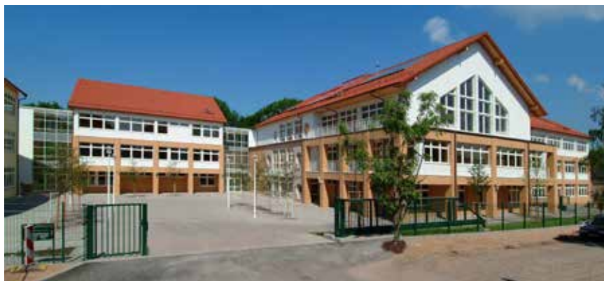
Die Rudolf-Hildebrand-Schule mit der Photovoltaikanlage
