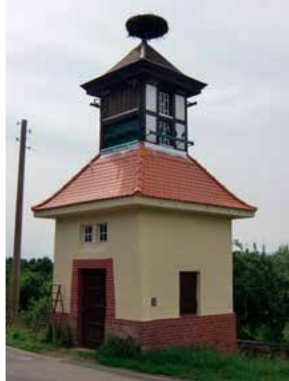
Das Trafohaus in Saasdorf
